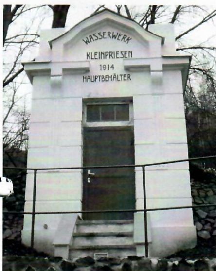
Opravený vodojem Malé Březno
