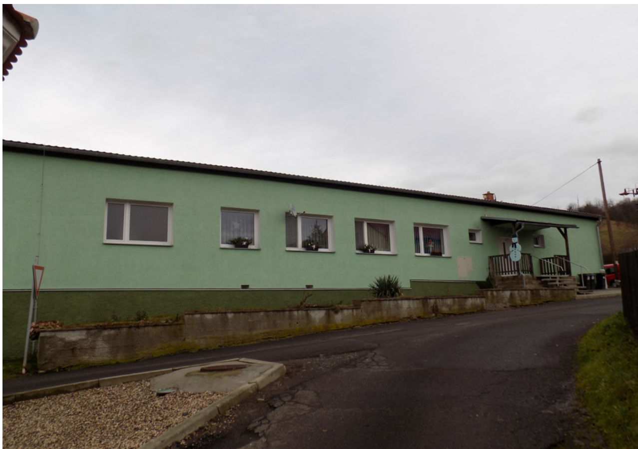
Obecní byty přestavěné z kina.
